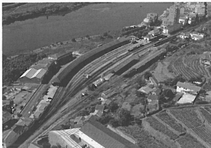
Figura n.º 21 – Estação da Régua (km 103,3)
