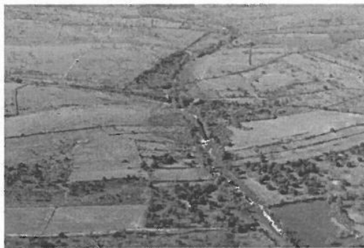
Figura n.º 37 – Ponte do Arroyo de Camaces 29 (60 m) – km 39+650
