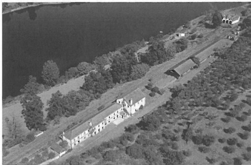
Figura n.º 31 – Estação de Barca D'Alva (km 199,5)
