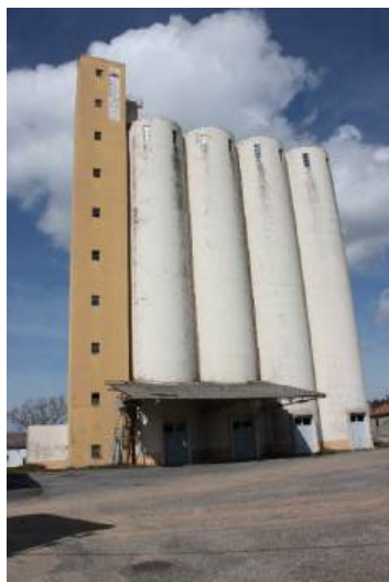
Figura 104 – Silos de Mogadouro, Celeiros de Sendim e de Duas Igrejas
