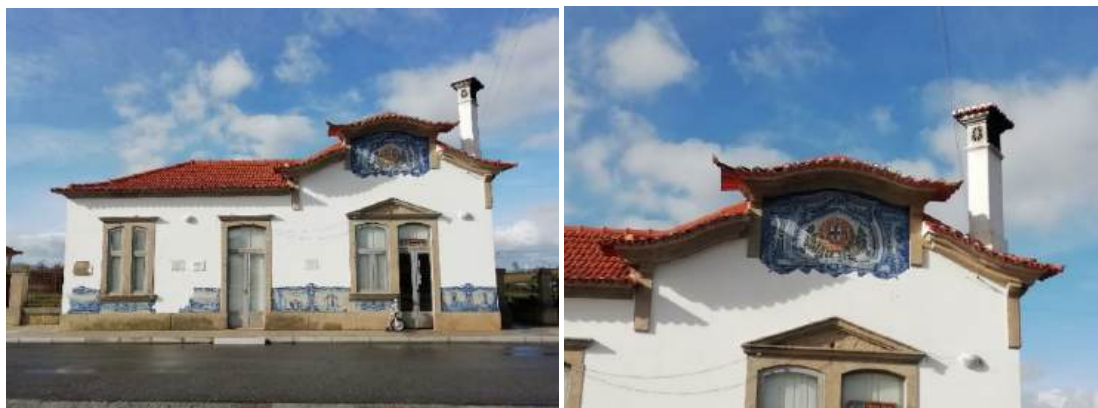
Fachada do Edifício de Passageiros
