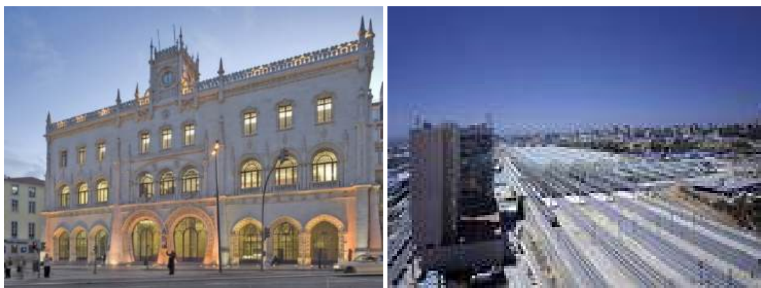
Figura 54 - Estação do Rossio (1887) e Gare do Oriente (1998)
