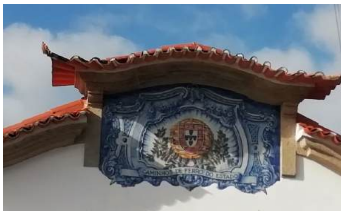
Painel da Fachada virada ao largo
