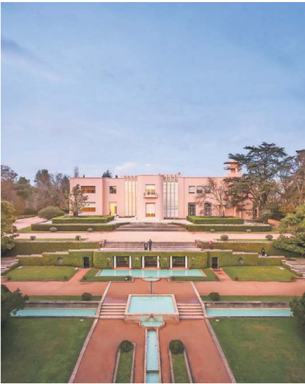
Fundação de Serralves, Porto
